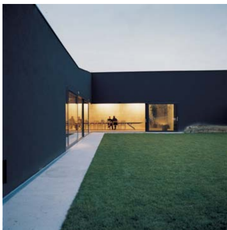
Der Wiener Architekt Andreas Burghardt erstellte für Loimer über den alten Kellergewölben einen modernen Neubau.
